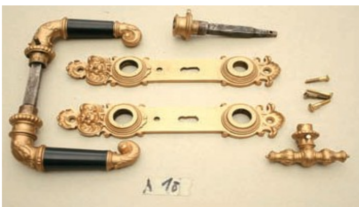
Obrázek 27, 28 - Dveřní kování před a po restaurování (3)
